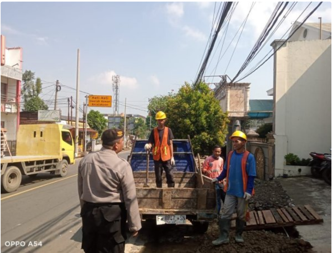
Kanit Samapta Polsek Gunungpuyuh Berikan Himbauan Kepada Pekerja Proyek Trotoar
